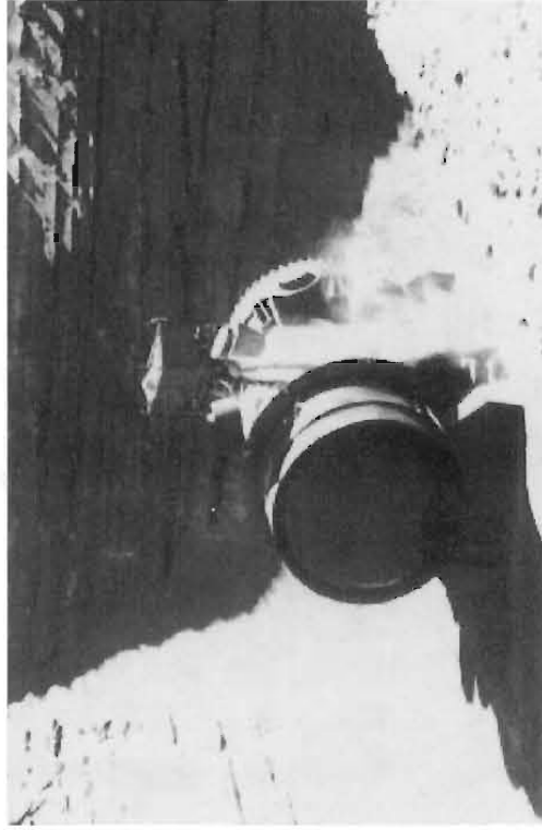
写真4 原子炉圧力容器の浅地中処分
