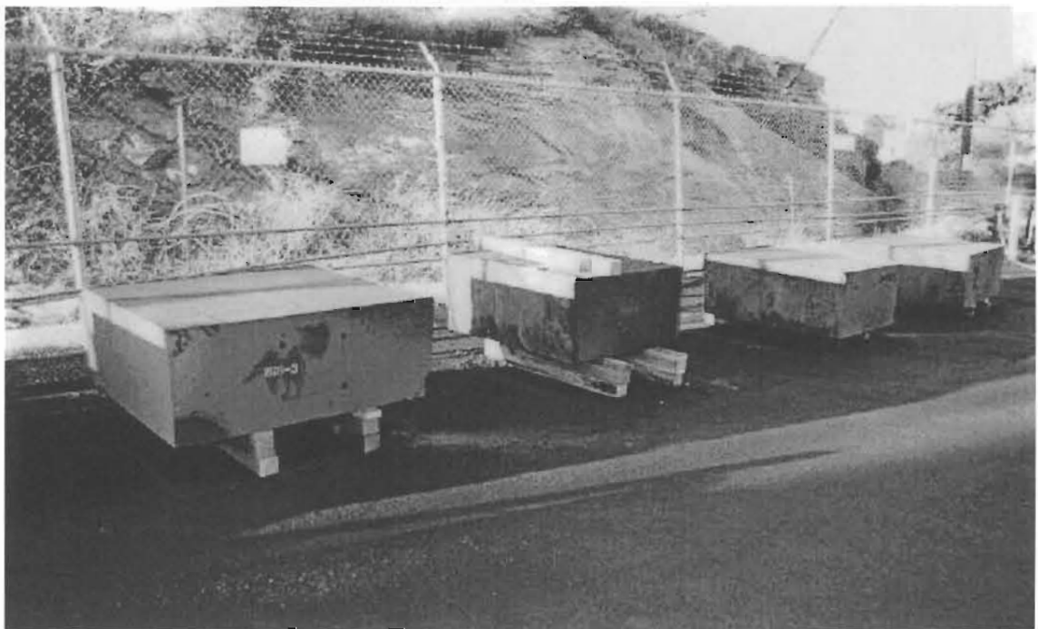
写真5 無拘束解放される切断後の遮へい扉
