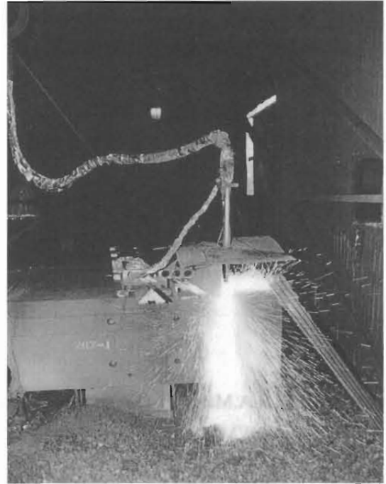
写真4 パウダージェットによる遮へい扉の切断
