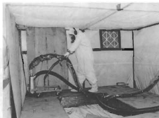
写真2 研磨材入りブラスティングによる除染
