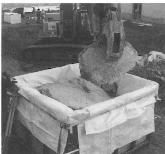
写真1 「軟壁」廃棄物容器への収納
