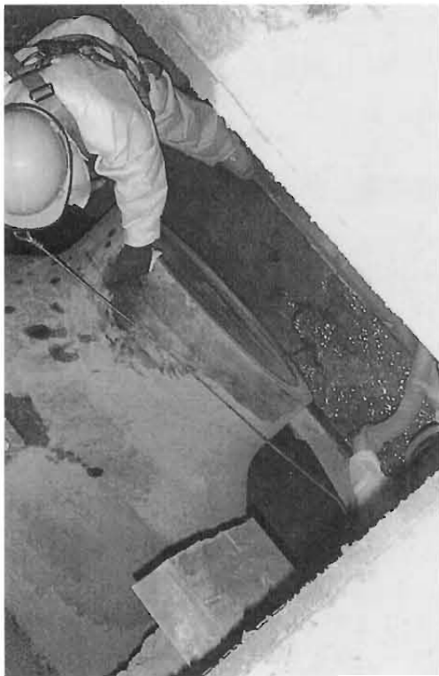
写真1 原子炉圧力容器ノズル部（ウォータージェットによる切断後）
